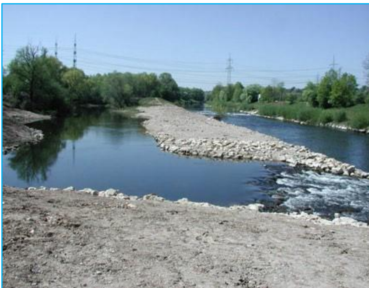
Újonnan létrehozott vízvisszatartó ág a Neckar folyón, Wernauban (Németország) - Forrás: www.pfrommer-roeder.de
