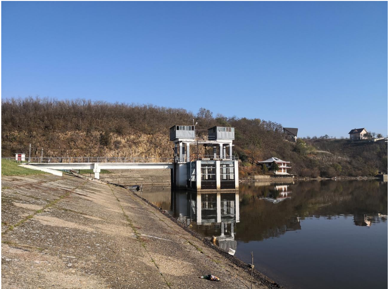
4. Ábra – A vezértorony és fenékkürtés a fénykép közepén, közelről a beton védőfal figyelhető meg
