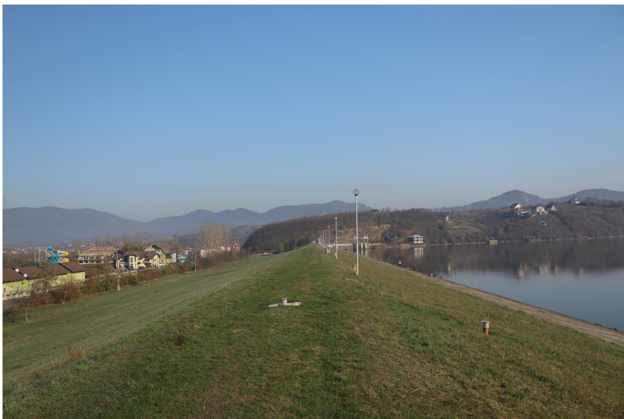
3. ábra – Kilátás a Călinești gátra, a gát felső részéről (a gát északi fele)
