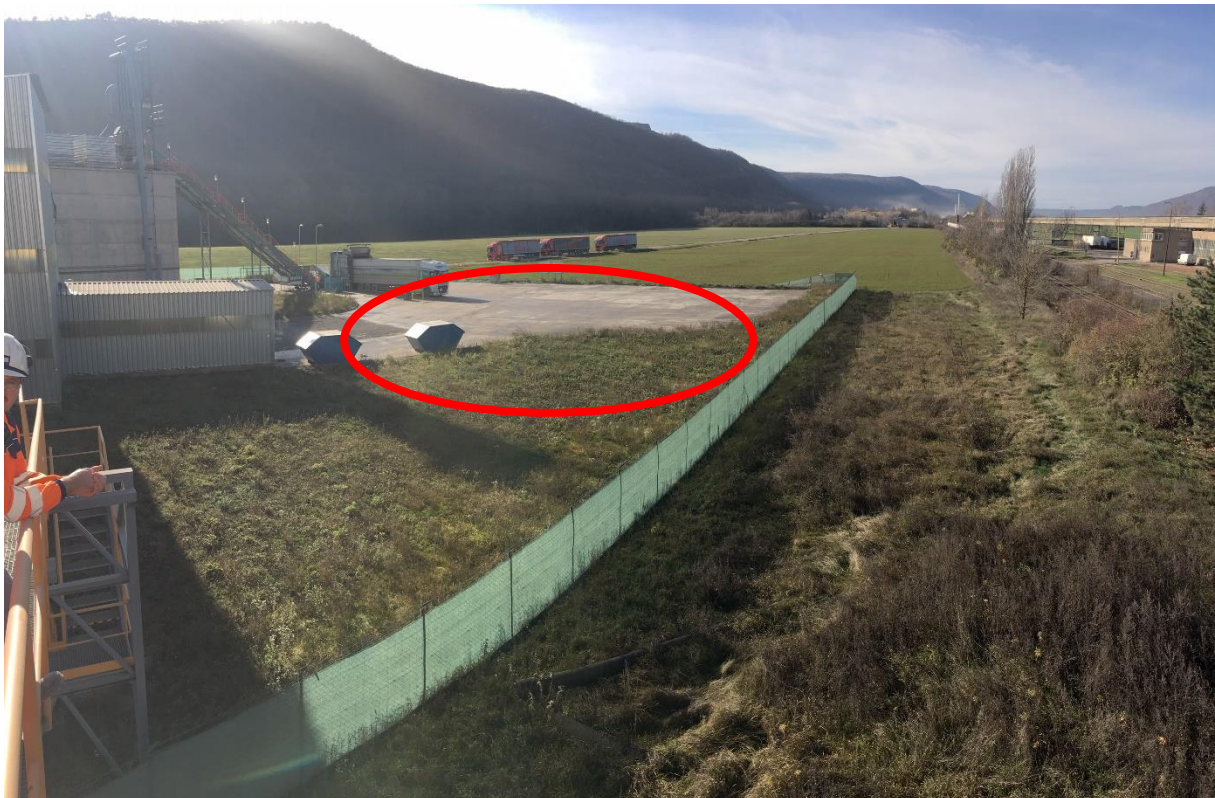
Obrázok č. 7: Pohľad na miesto realizácie novej prevádzky
