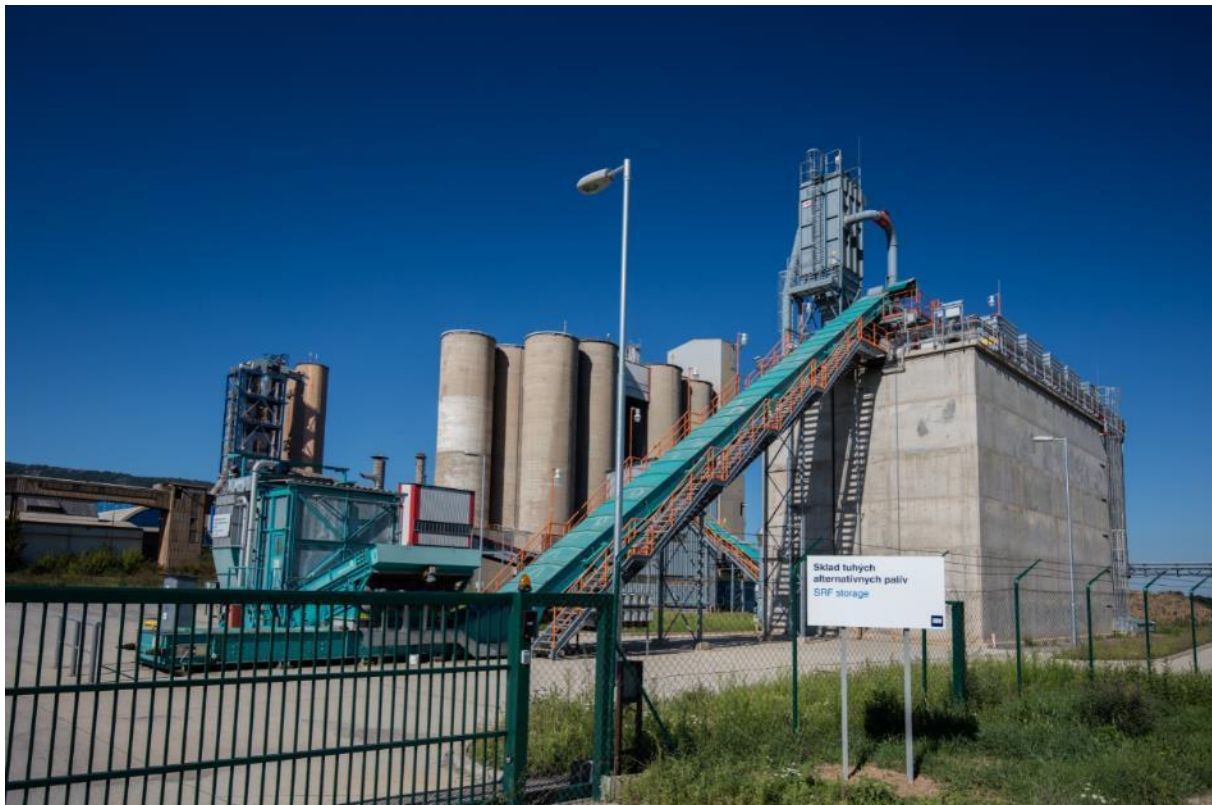
3. ábra: Meglévő "TAP 200" szilárd alternatív tüzelőanyag-tárolók
