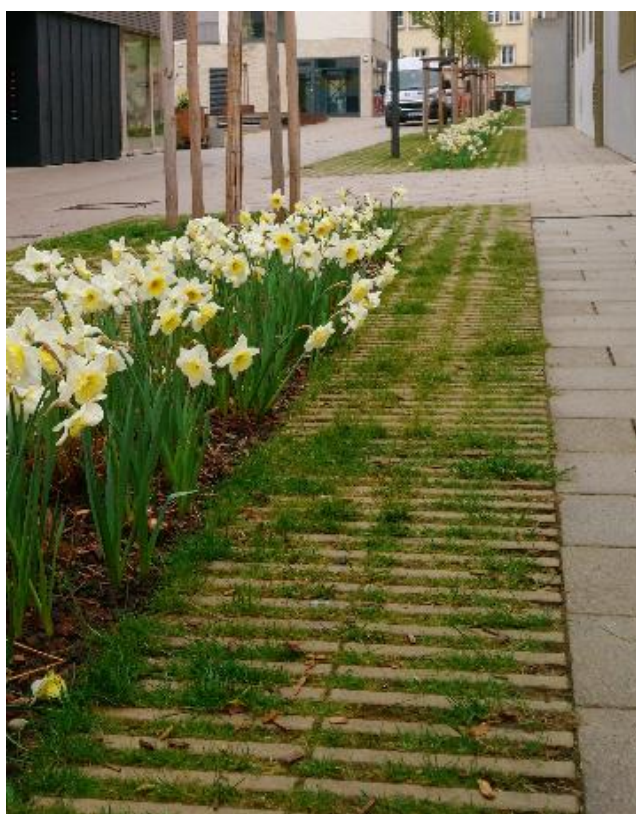
Áteresztő burkolatrendszer Stuttgartban, Németországban. – Forrás: UNaLab 13
