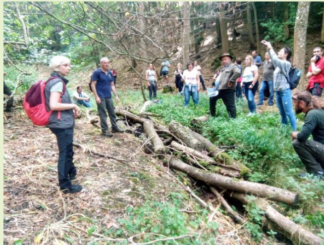
Vízmosáskötés, árokkelzés © Kerpely Klára
